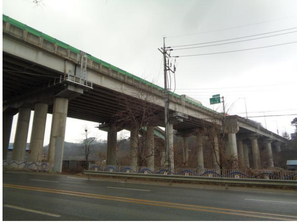
교량 측면 전경
