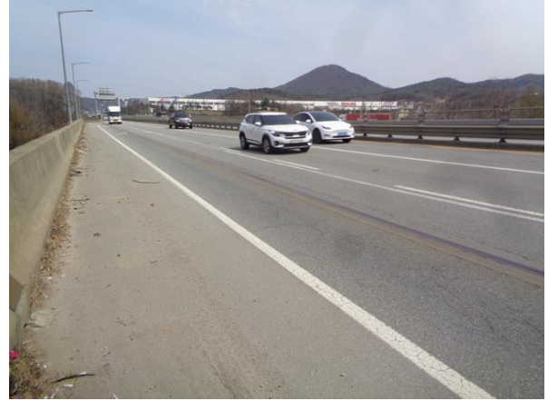
교량 상부 전경
